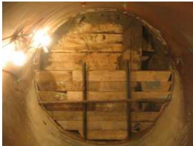
<그림 8> 막장안정 관마개 전경
