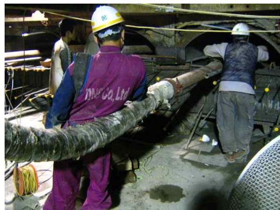
8) 관내부 콘크리트 타설
