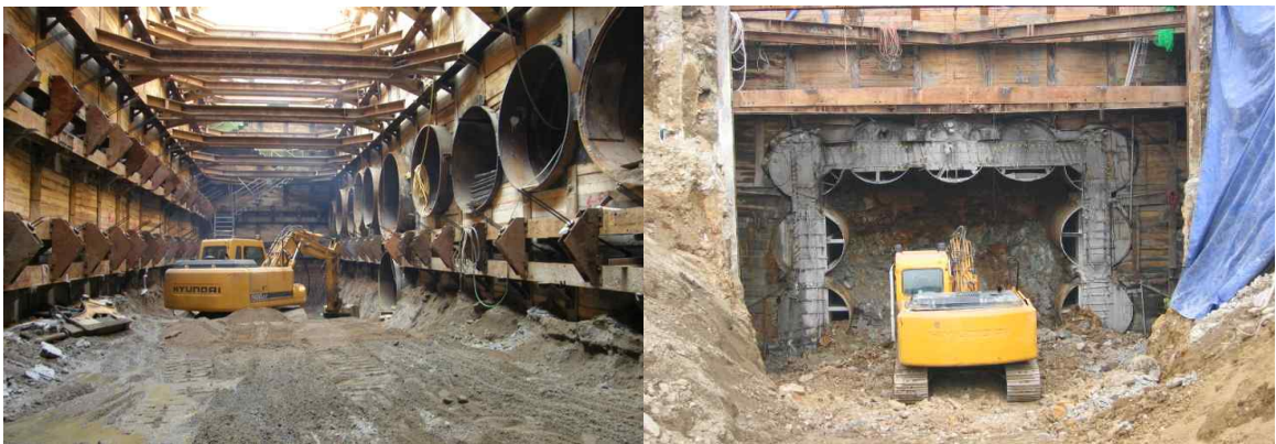
<그림 3> NTR공법을 이용한 터널공사
