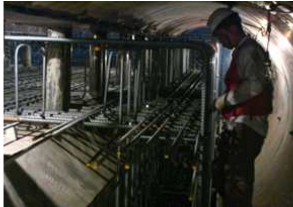
<그림 11> 강관내 철근배근 전경
