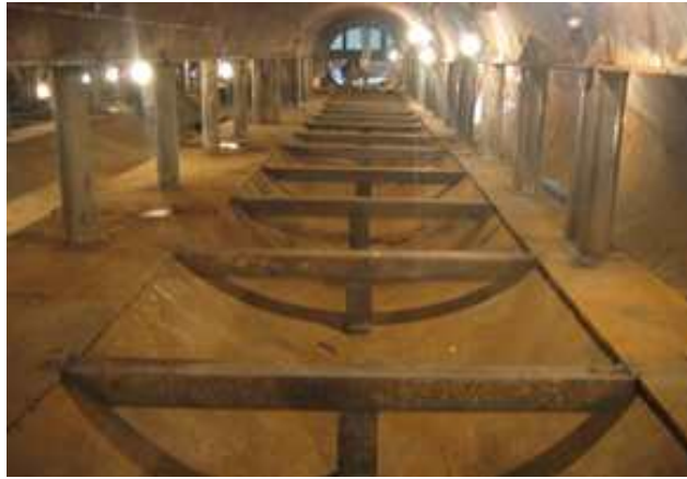
<그림 10> 강관내 강재동바리 설치 전경
