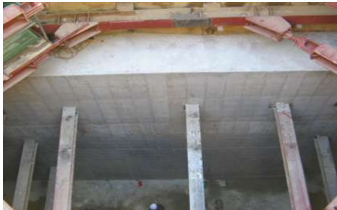
<그림 6> 반력벽 설치 전경
